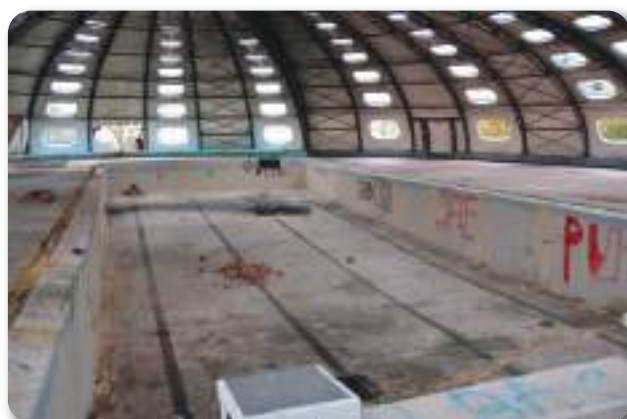
Le bassin juste avant la démolition.
